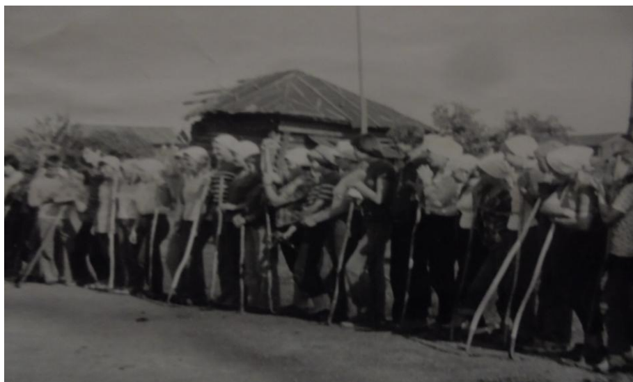
Сбор бригады перед работой.
